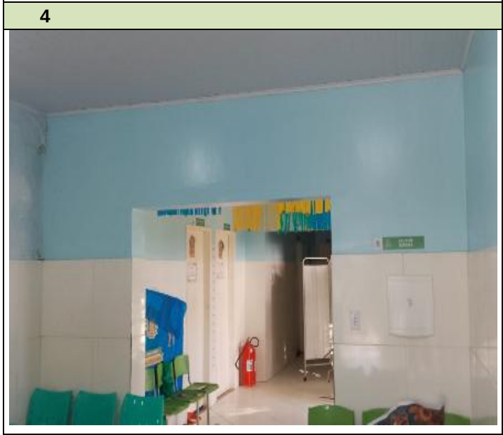
DESCRIÇÃO PINTURA INTERNA EM TINTA ESMALTE SINTÉTICO
