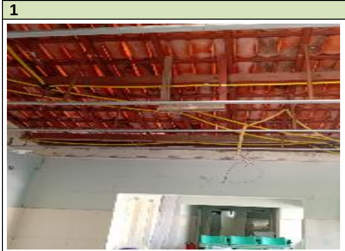
DESCRIÇÃO EXECUÇÃO DO FORRO USB MIRANGA
