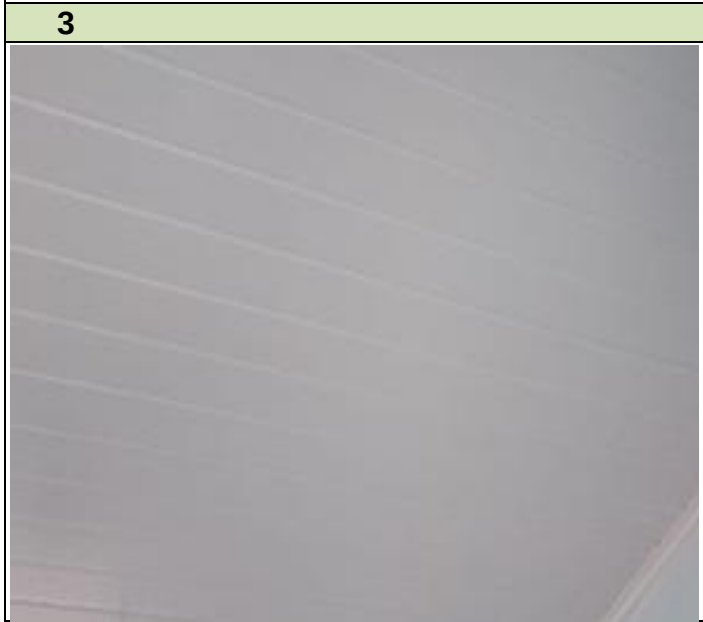
DESCRIÇÃO FORRO EM PVC EXECUTADO NO USB MIRANGA
