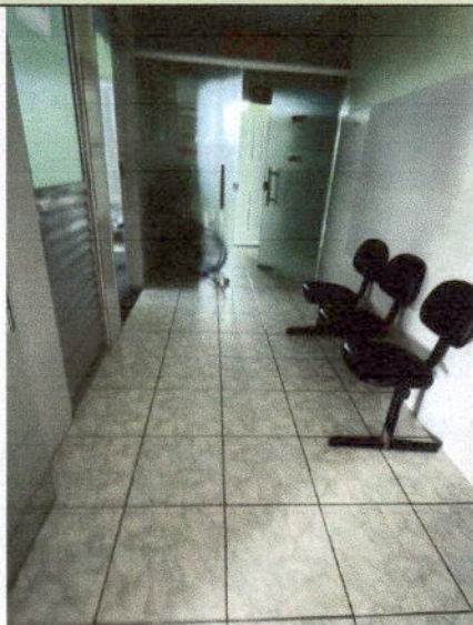
Vista do corredor de acesso interno.
