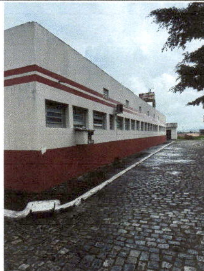
Vista lateral – pavimentação com paralelepípedo
