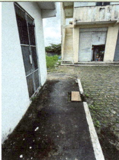
Vista do passeio lateral direito da edificação, registrando as condições existentes antes da intervenção de recuperação de todos os passeios.
