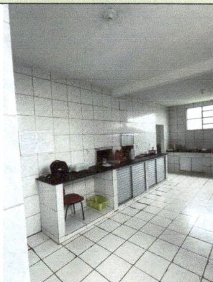
Vista da área da cozinha, registrando as condições existentes dos revestimentos e acabamentos.
