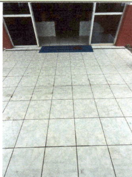
Vista da entrada principal da edificação, evidenciando os acabamentos existentes.
