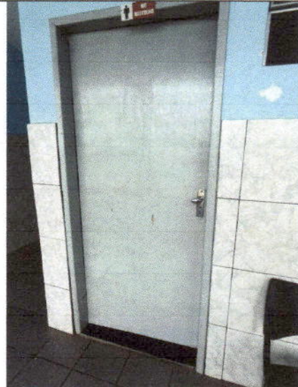
Vista da porta do banheiro, prevista para substituição.
