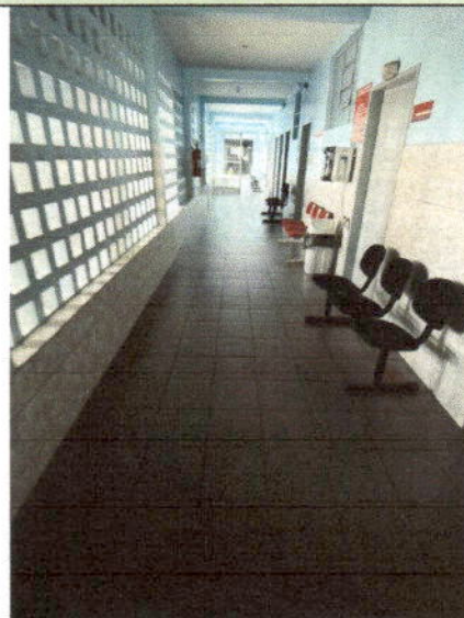
Vista complementar do corredor de acesso interno, onde será feita demolição da parede de cobogó e demolição de revestimentos das paredes.
