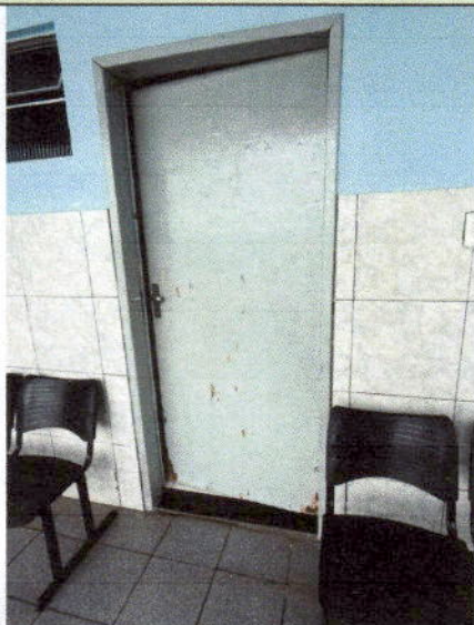
Vista da porta de acesso ao consultório, prevista para substituição durante a reforma.
