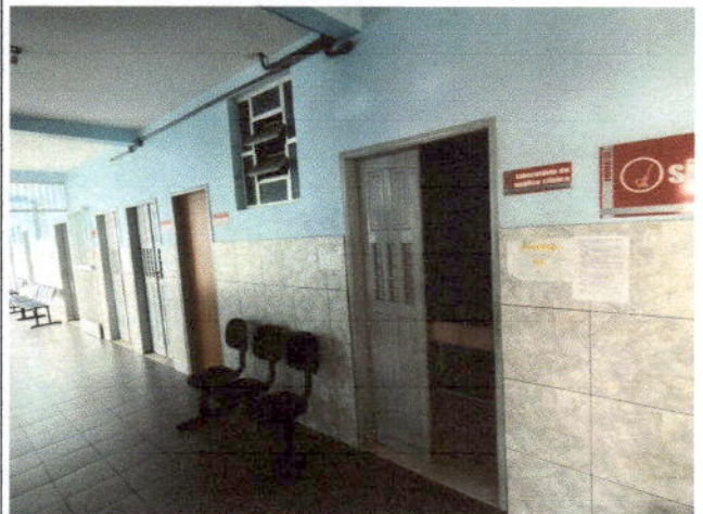
Vista do corredor de acesso interno, prevista para substituição de portas.
