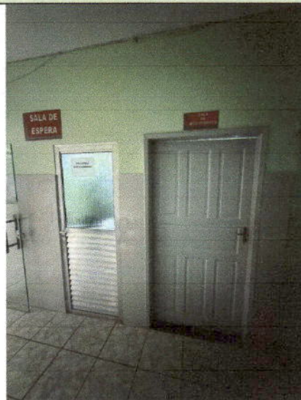
Vista das portas das sala de espera e acolhimento, prevista para substituição.
