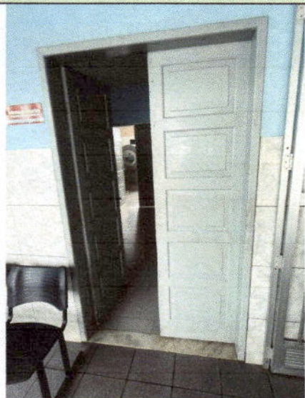
Vista da porta da lavanderia, prevista para substituição durante a reforma.
