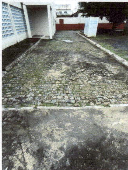
Vista lateral – pavimentação com paralelepípedo
