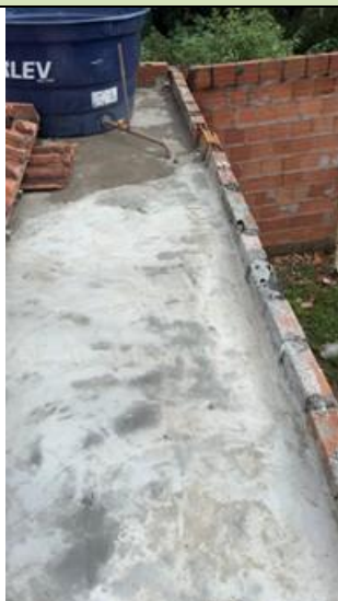
Vista da laje
