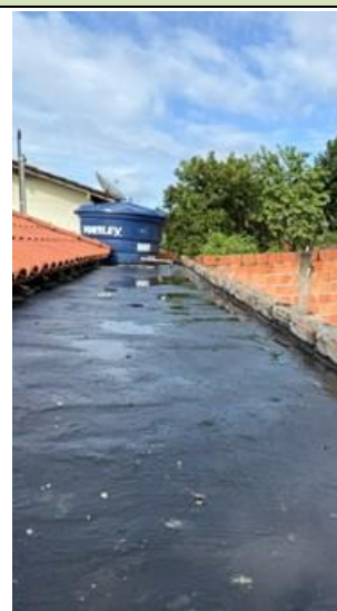
Serviço: Impermeabilização com manta asfáltica
