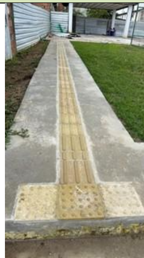
Serviço: Piso podotátil
