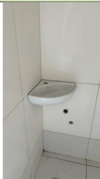
Serviço: Instalação de lavatório
