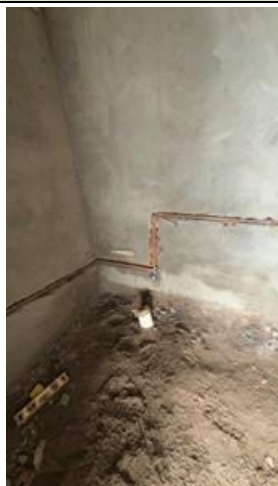
Vista do banheiro
