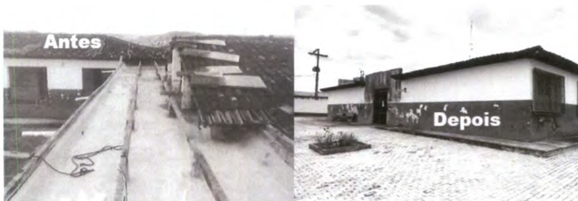
Lote 02: Reforma do Setor de Tributos do Município de Pojuca – Bahia
