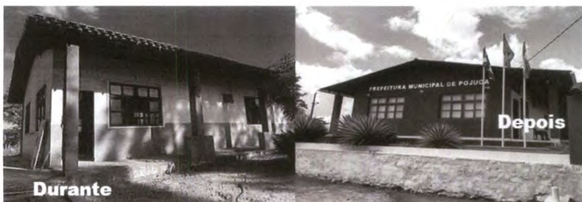
Execução dos serviços de reforma de prédio para funcionamento temporário da Prefeitura do Município de Pojuca – Bahia
