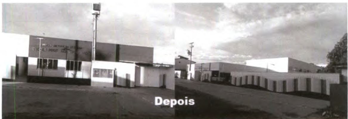
Construção da Escola Eudes José Argolo Guimarães no Bairro Los Angeles no município de Pojuca - Bahia
