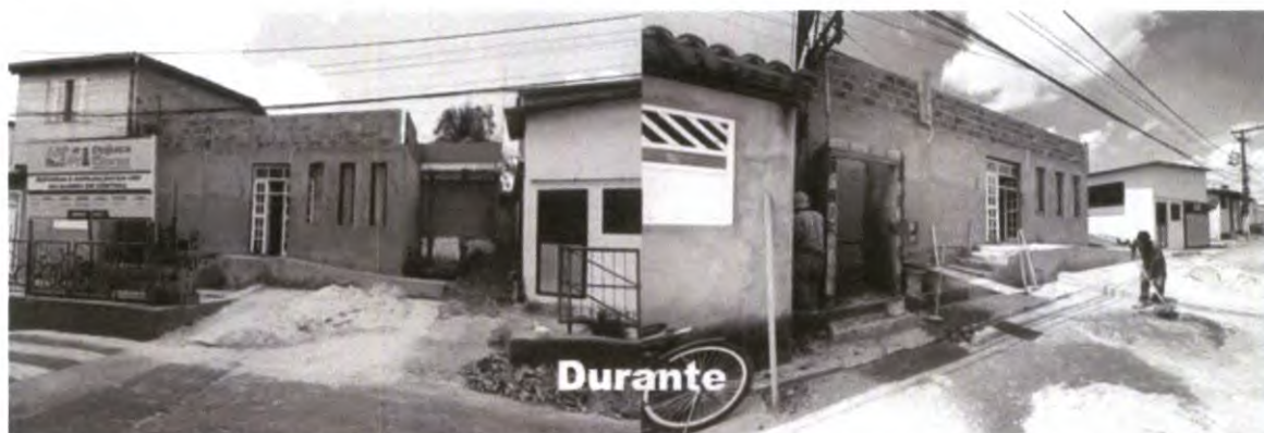
Execução dos serviços de reforma de Unidade de Saúde da Família de Central no Município de Pojuca – Bahia
