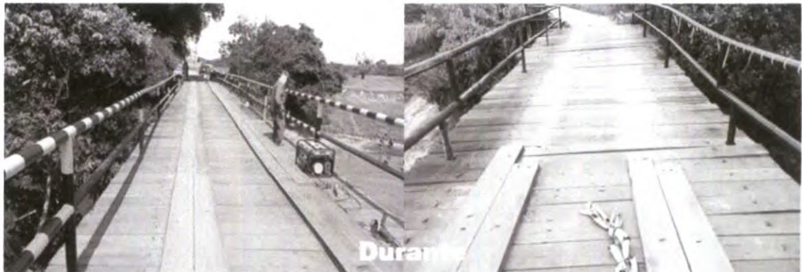
Execução dos serviços de reforma de pontes da Zona Rural (Beira Rio, Campo de Central, Marimbondo, Fazenda Riacho Doce, Araponga, Mariquita e Quiricó) no Município de Pojuca - Bahia.
