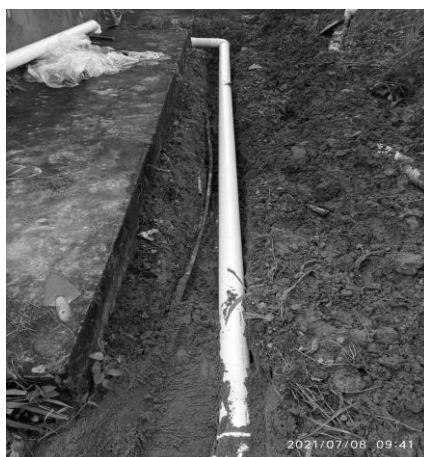
Figura 22 – Revisão Hidráulica na Escola Municipal Nelson Xavier.
