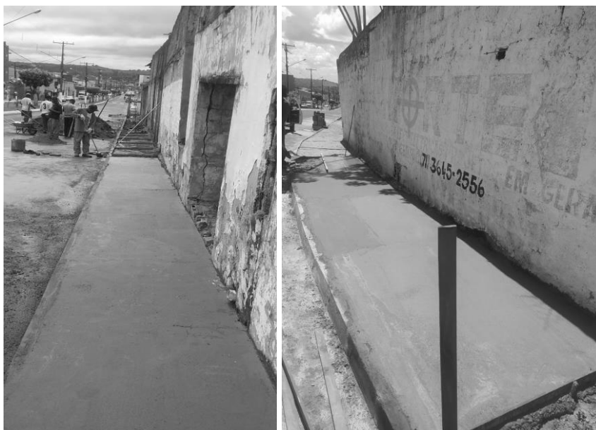
Figuras 8 e 9 – Instalação de meios-fios e construção de passeio, Avenida Antônio Batista e Avenida Percílio dos Santos.
