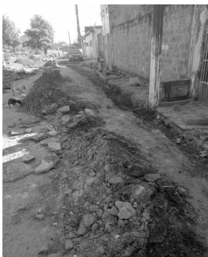
Figura 7 – Rede construída na Rua da Piedade, bairro da Nova Pojuca.
