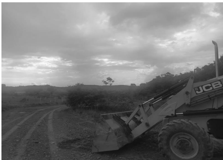
Figura 3 – Manutenção de estrada vicinal realizada na Localidade do Coqueiro.
