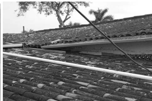
Figuras 15, 16 e 17 – Limpeza do telhado e substituição de calha danificada, Escola Municipal João Costa Libório.
