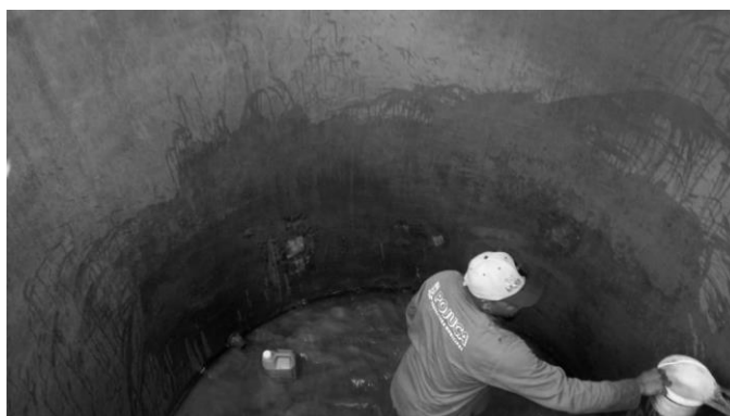
Figuras 24 – Limpeza de tanque da Localidade do Miranga.
