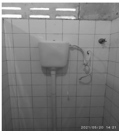
Figura 23 – Substituição de descarga CEAAP.
