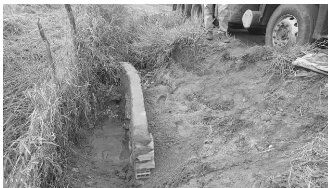
Figuras 19 - Execução de ponta de ala da Localidade do Lameiro Branco.
