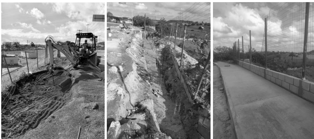
Figuras 12, 13 e 14 – Execução de estrutura de contenção de movimentação do solo, Hospital Dr. Carlito Silva.
