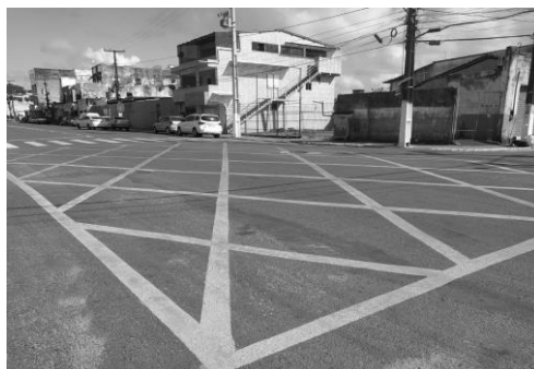
Figura 20 – Pintura de faixas e quebra-molas, Praça ACM.
