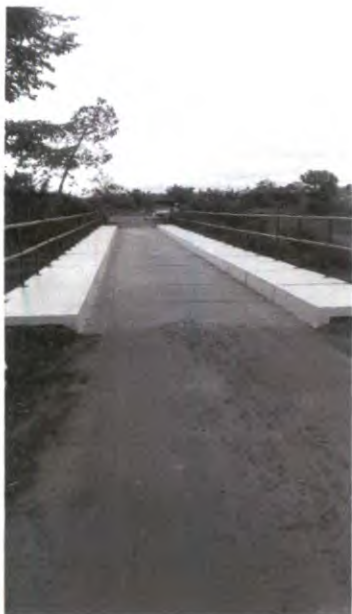
Figura 12 - Sinalização da Ponte da Localidade do Cajueiro.
