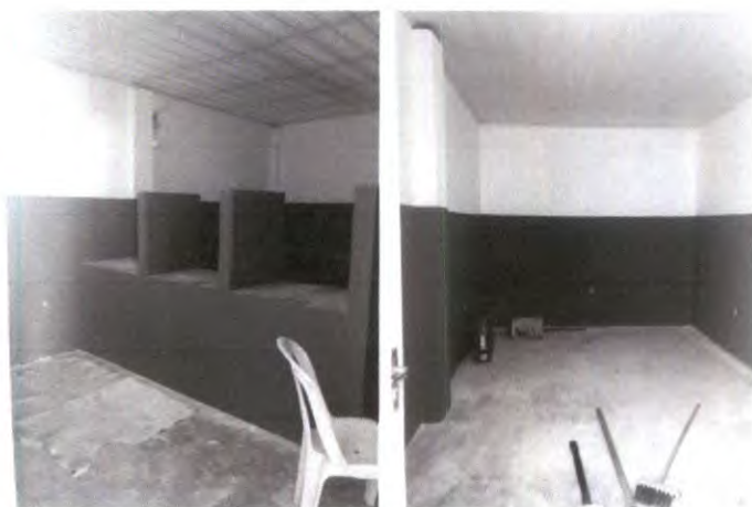
Figuras 9, 10 - Construções de duas salas, no prédio da SESPUMA.
