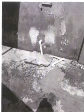
Figura 13 – Desentupimento com troca de tubulação na rede de esgoto da Escola M. Nilza Silva Rego
