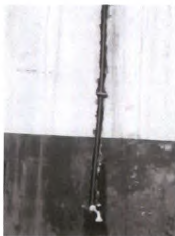
Figura 14 – Instalação de ponto de água com torneira, na garagem municipal.
