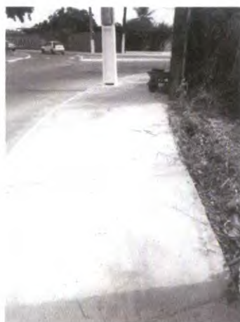
Figuras 7 – Instalação de meios-fios e construção de passeio, Avenida Antônio Batista.
